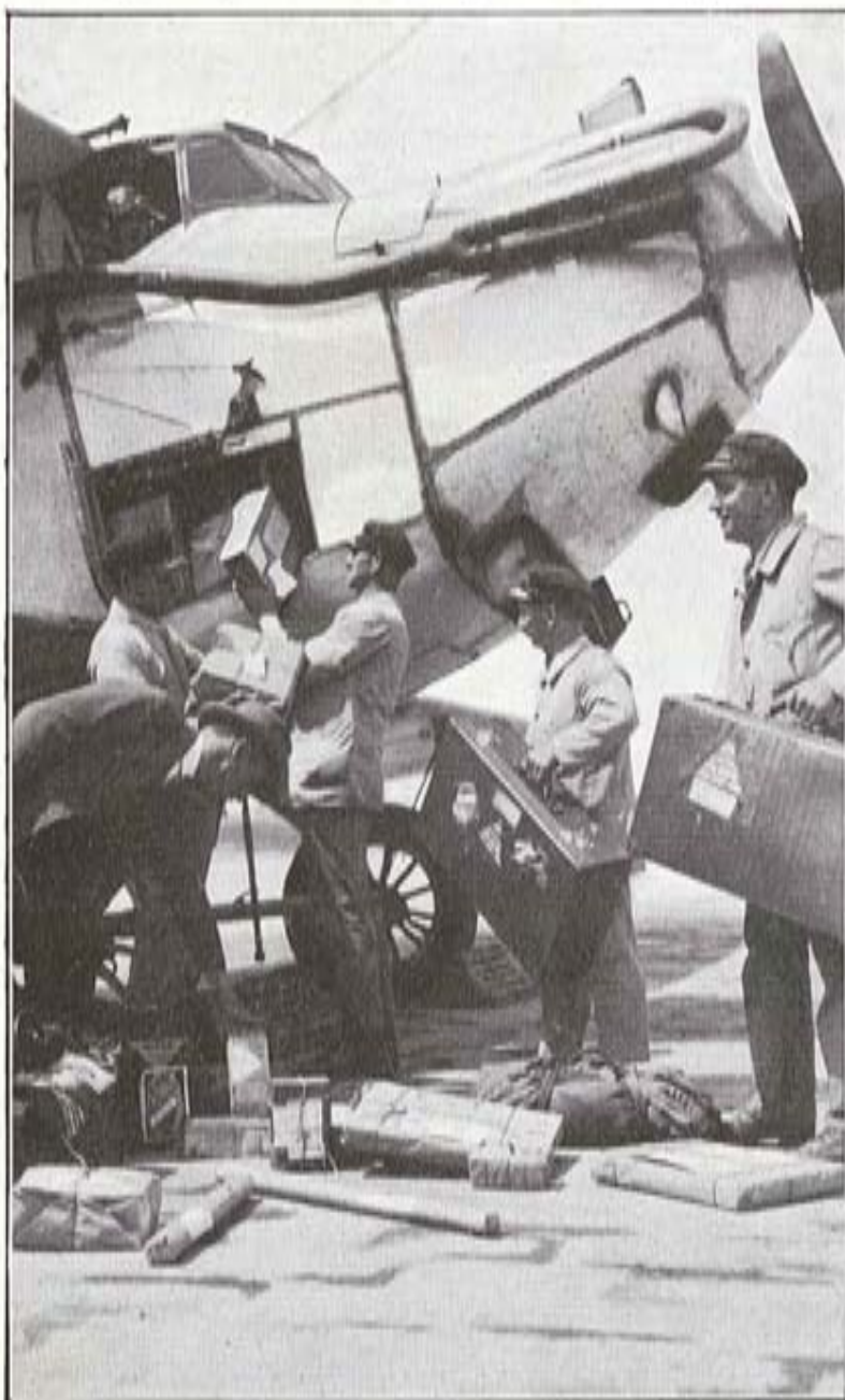
Le chargement des bagages dans le coffre à bagages avant du Breguet 280 T (avion à moteur Lorraine 450 cv, démultiplié).
